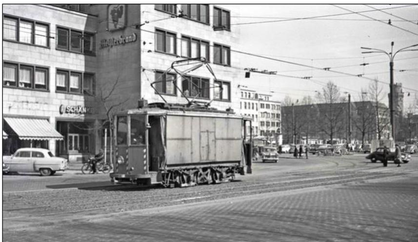
**oben:** Die Kölner Verkehrsbetriebe (KVB) setzten schon früh Schienenfahrzeuge zur Gleisreinigung ein. Der Arbeitstriebwagen 3003 hatte am 28. März 1955 den Neumarkt verlassen und fuhr zum Rudolfplatz.
