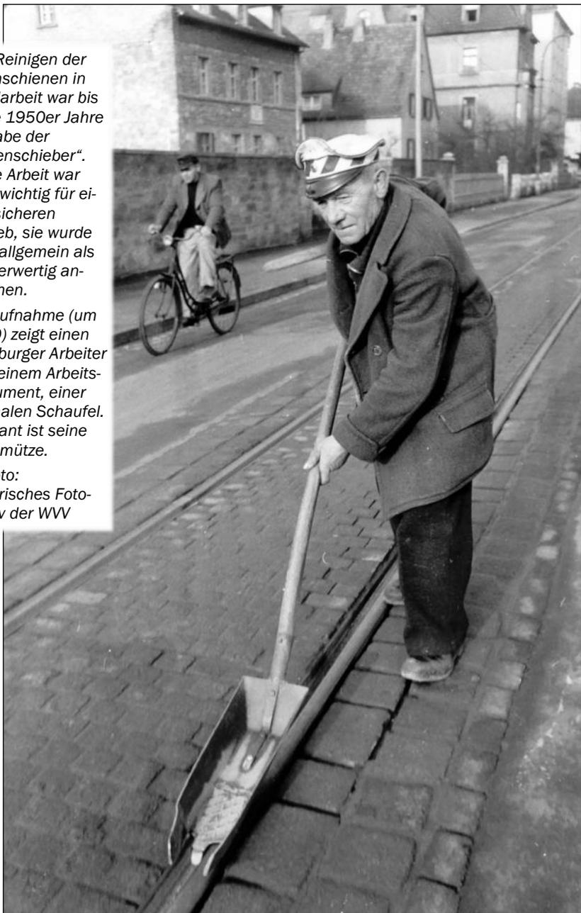
Bei Eis und Schnee war die Schienenreinigung besonders wichtig, vereiste Rillenschienen bedeuteten Entgleisungsgefahr.
